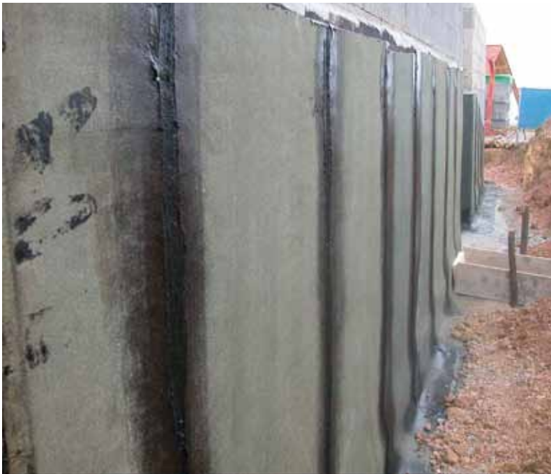
Bild 11: Ausführungsbeispiel einer schwarzen Wanne mit Bitumen-Schweißbahnen
