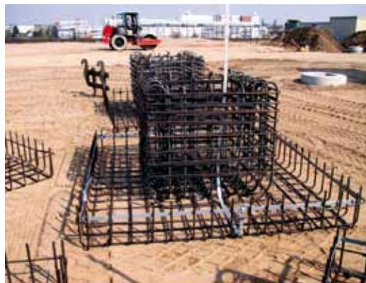
Bild 15: Fundamenterder und Anschlussfahne bei einem Einzelfundament
