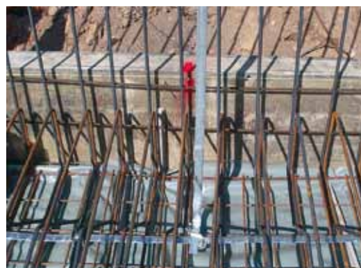
Bild 18: Ausführungsbeispiel einer Anschlussfahne aus Edelstahl (V4A)
