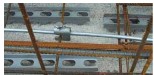
Bild 9: Ausführungsbeispiel eines Fundamenterders in der unteren Bewehrungslage
