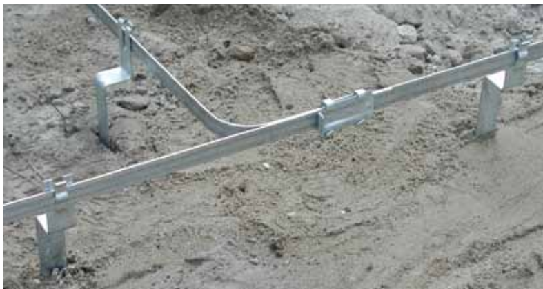
Bild 7: Abstandhalter und Keilverbinder montiert in der Sohle
