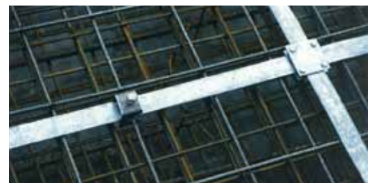
Bild 7: Abstandhalter und Keilverbinder montiert in der Sohle
