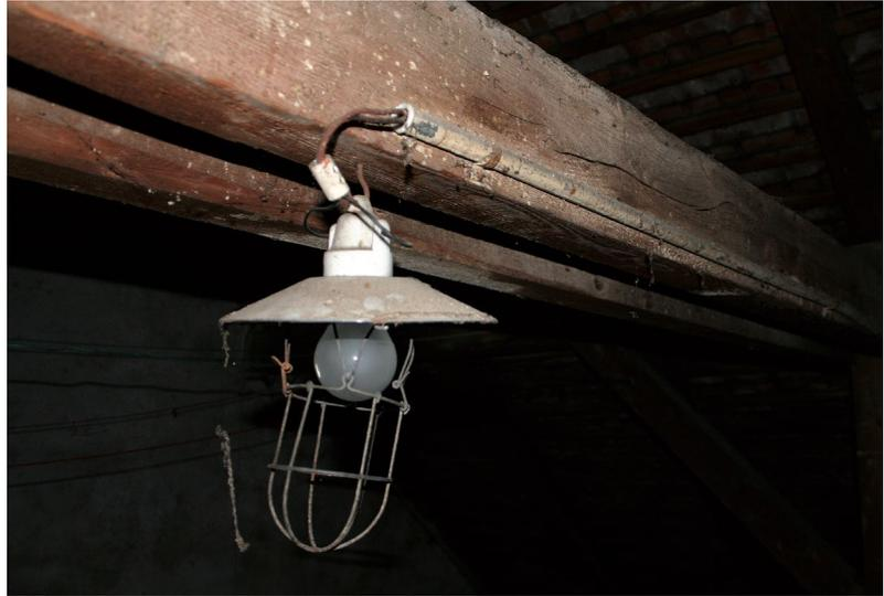
Bild 10: Brandgefahr durch schlecht isolierte Leitung für eine Leuchte im Dachgebälk
