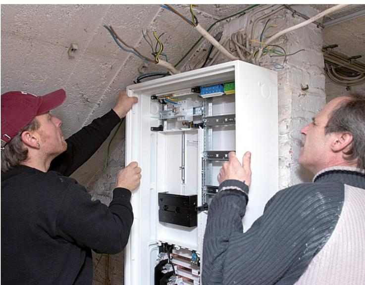
Der Austausch der alten Blechzählertafel gegen einen neuen Zählerschrank mit modernen Schutzgeräten steigert das Schutzniveau der gesamten elektrischen Anlage.
