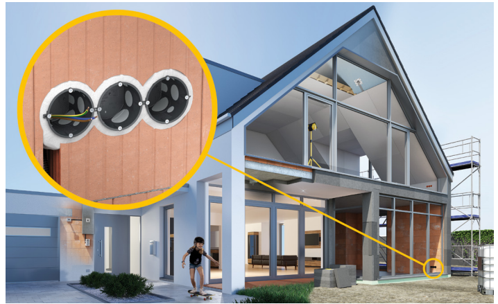
Luftdichte Elektroinstallation bei Massivbauweise
