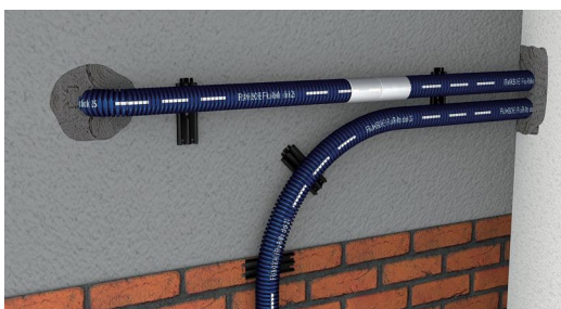
Nachrüstung der Elektroinfrastruktur bei Dämmarbeiten im Baubestand
