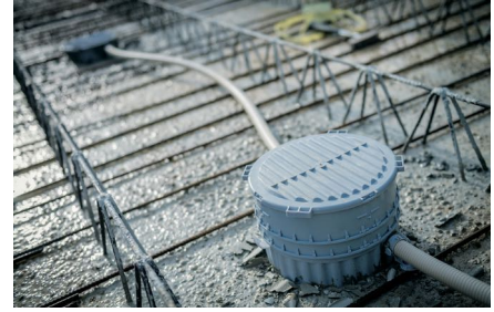
Gehäusesysteme z. B. für Leuchten oder Lautsprecher mit werkzeugloser Kombieführung und integriertem Rohrrückhalt sorgen für die Durchgängigkeit des Leerrohrsystems
