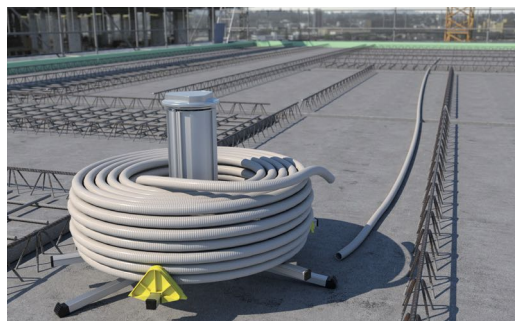
Elektroinstallationsrohre für die Betoninstallation lassen sich problemlos gerade ausrollen
