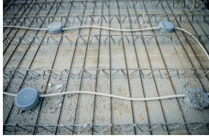
Gehäusesysteme z. B. für Leuchten oder Lautsprecher mit werkzeugloser Kombieführung und integriertem Rohrrückhalt sorgen für die Durchgängigkeit des Leerrohrsystems
