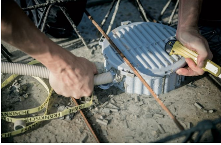
Gehäusesysteme z. B. für Leuchten oder Lautsprecher mit werkzeugloser Kombieführung und integriertem Rohrrückhalt sorgen für die Durchgängigkeit des Leerrohrsystems
