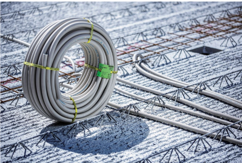
Elektroinstallationsrohre für die Betoninstallation
