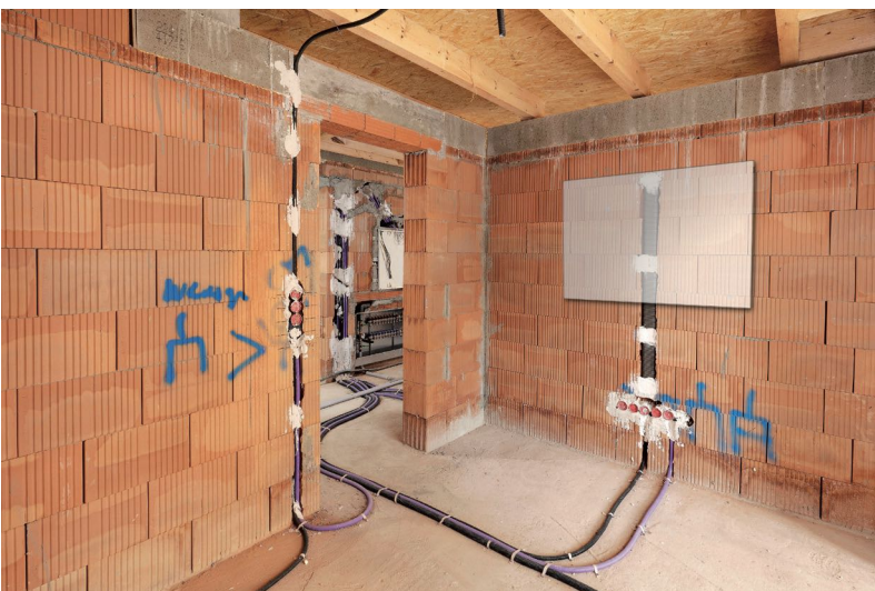
Leerrohrinstallation im Mauerwerk
